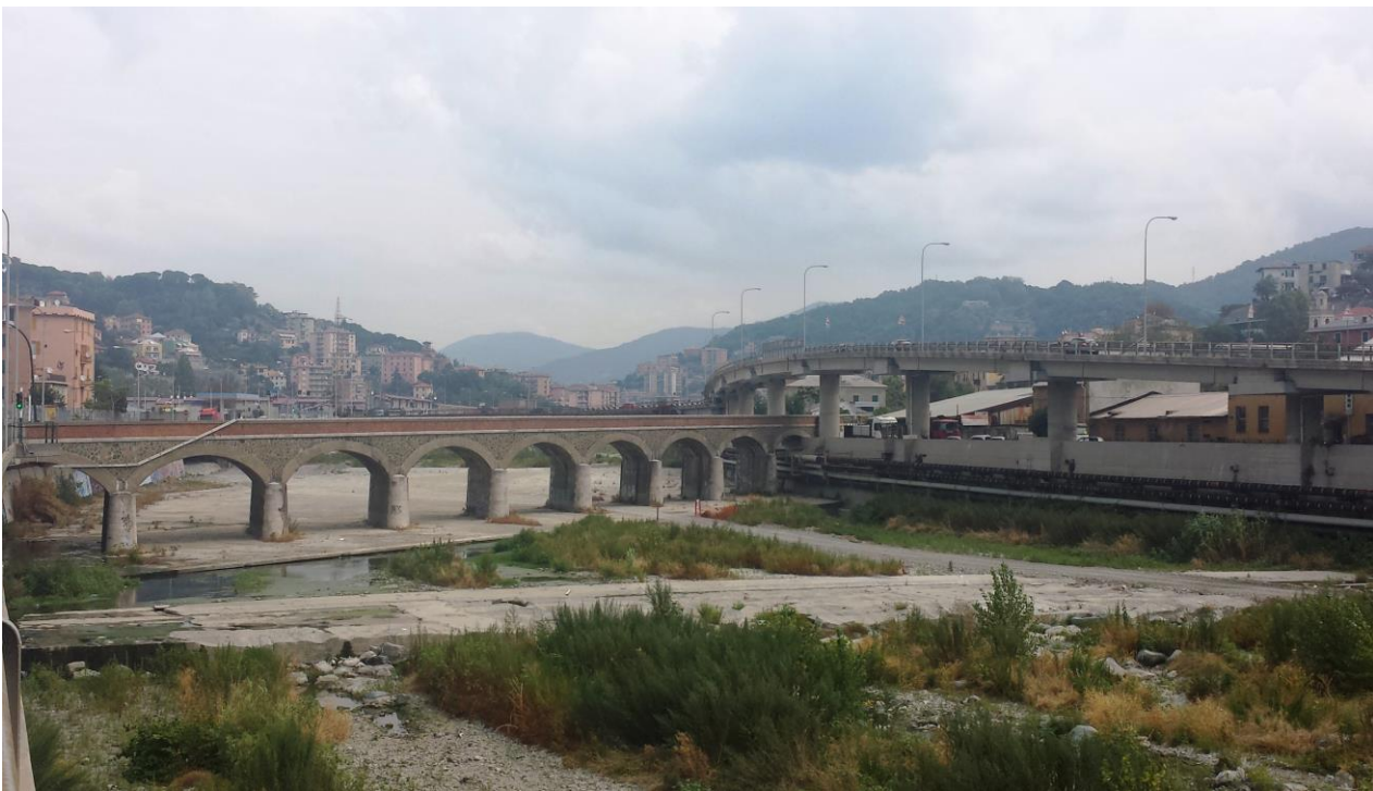
Ponte ferroviario sul Polcevera che collega le tratte della sponda destra e sinistra del torrente
